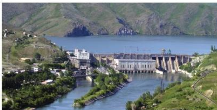
Рис. 142. Усть-Каменогорская гидроэлектростанция на реке Ертис
