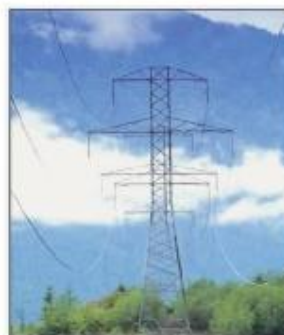
Рис. 2. Летом провода линий электропередачи, удлиняясь в результате расширения, провисают.
